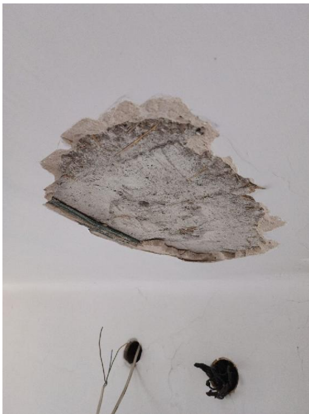
Fot. 1 – przewiert przez strop
