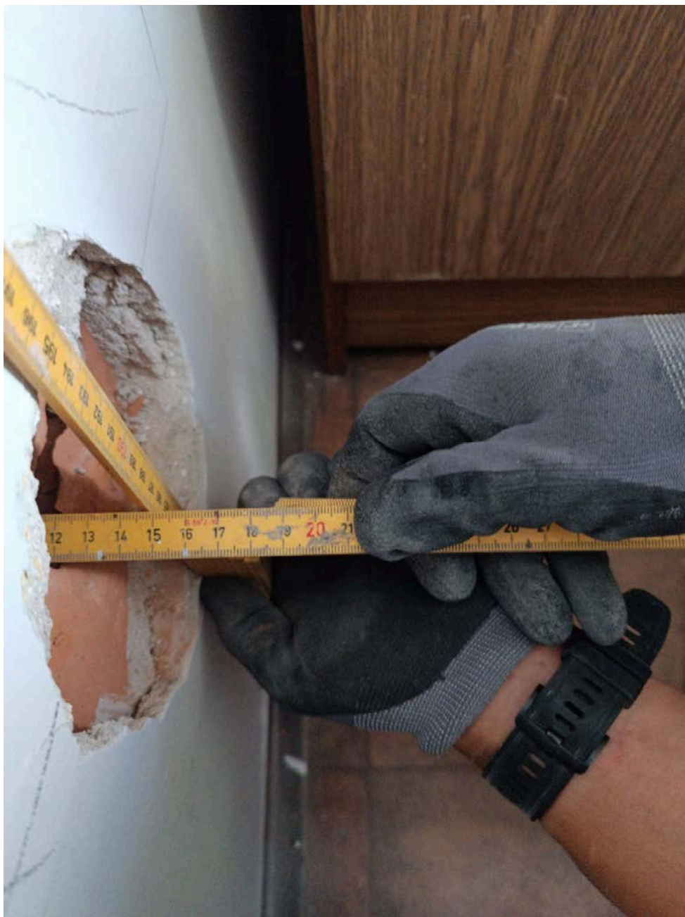
Fot. 5 – przewiert przez ścianę
