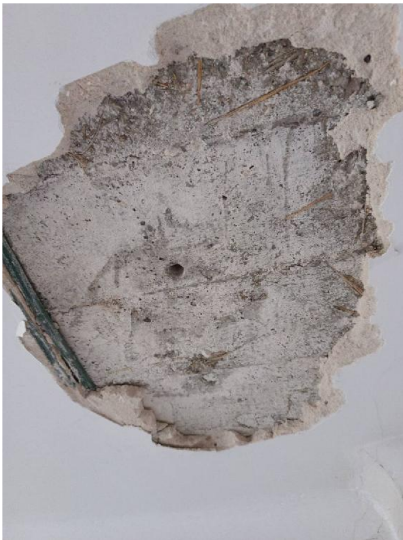
Fot. 2 – przewiert przez strop
